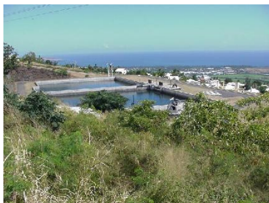
Source Photo : Département - Réservoir de Mon Repos
